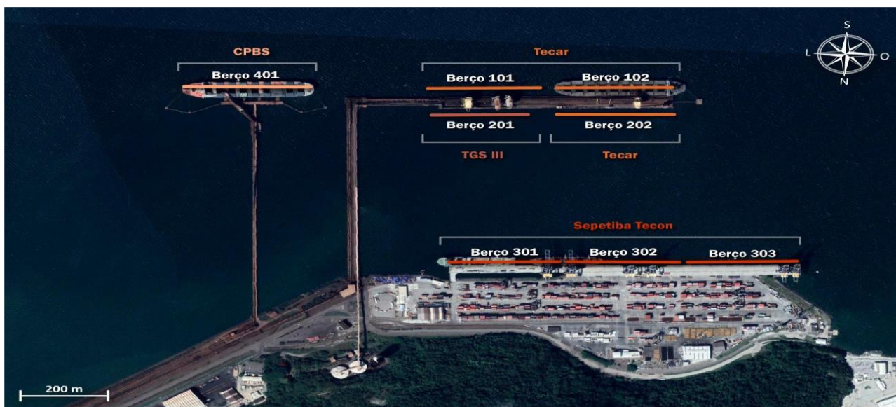
Figura 2 – Infraestrutura de acostagem do Porto de Itaguaí. Fonte: Plano Mestre do Complexo Portuário de Itaguaí 2019.
